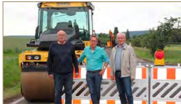
Main-Kinzig-Kreis führt Straßendeckensanierungen in Linsengericht aus
